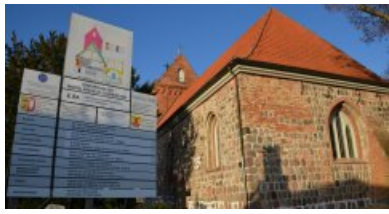
Mit der neuen Finanzspritze kann die Sanierung des Mauerwerks vorangetrieben werden. ©
