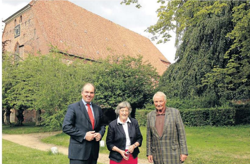
Das Dach der Preetz Klosterkirche wirkt recht intakt, muss aber dringend saniert werden. Die Nachricht des CDU-Bundestagsabgeordneten Philipp Murmann (links), dass die Preetzler aus Mitteln des Denkmalschutzes 120 000 Euro bekommen, wurde daher von Priörin Viktoria von Flemming und Klosterprobst Eckhard Graf von Hahn erfreut aufgenommen. FOTO: INGA FAHLBUSCH
